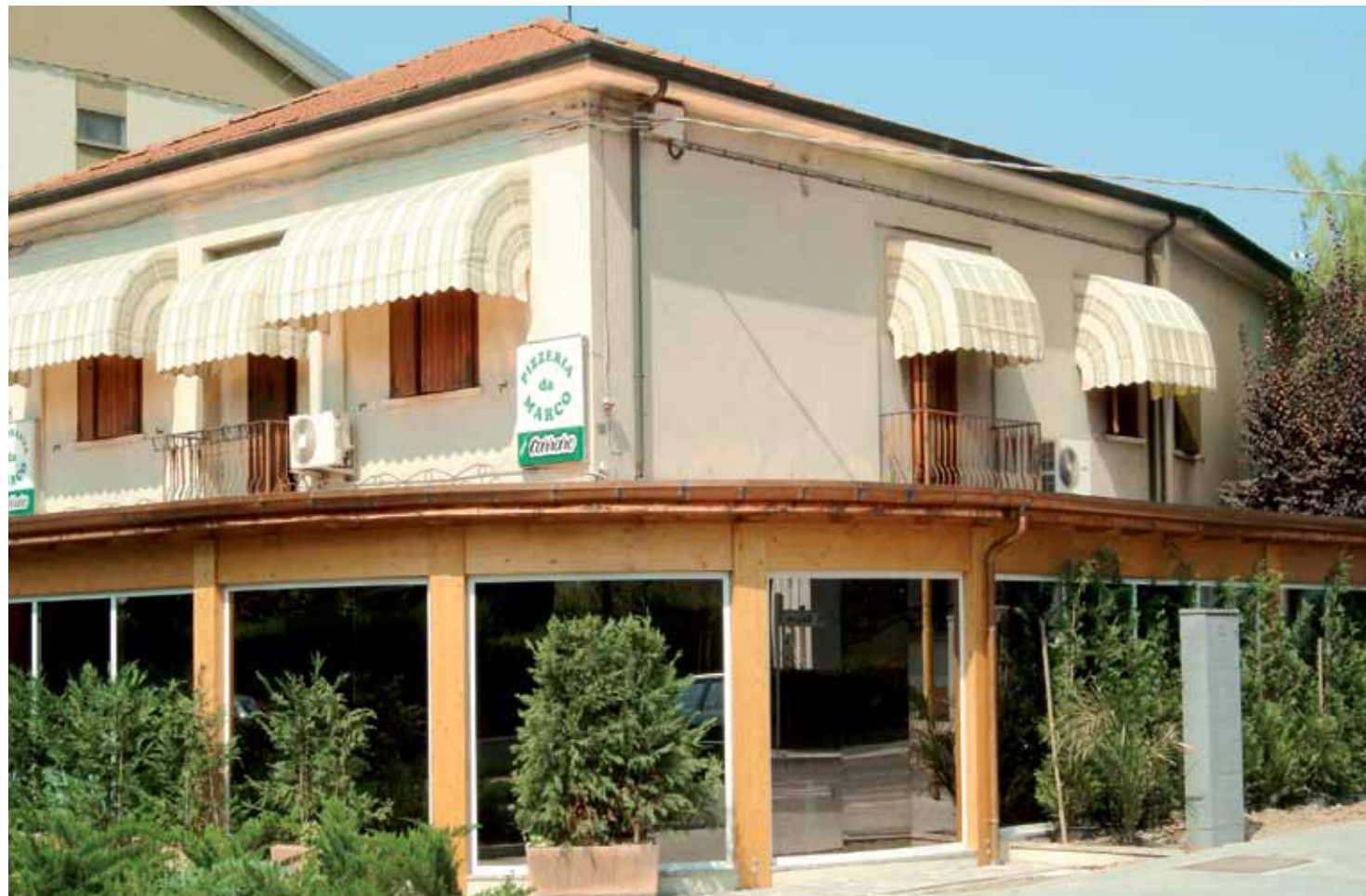
Copertura abete lamellare con curvatura
