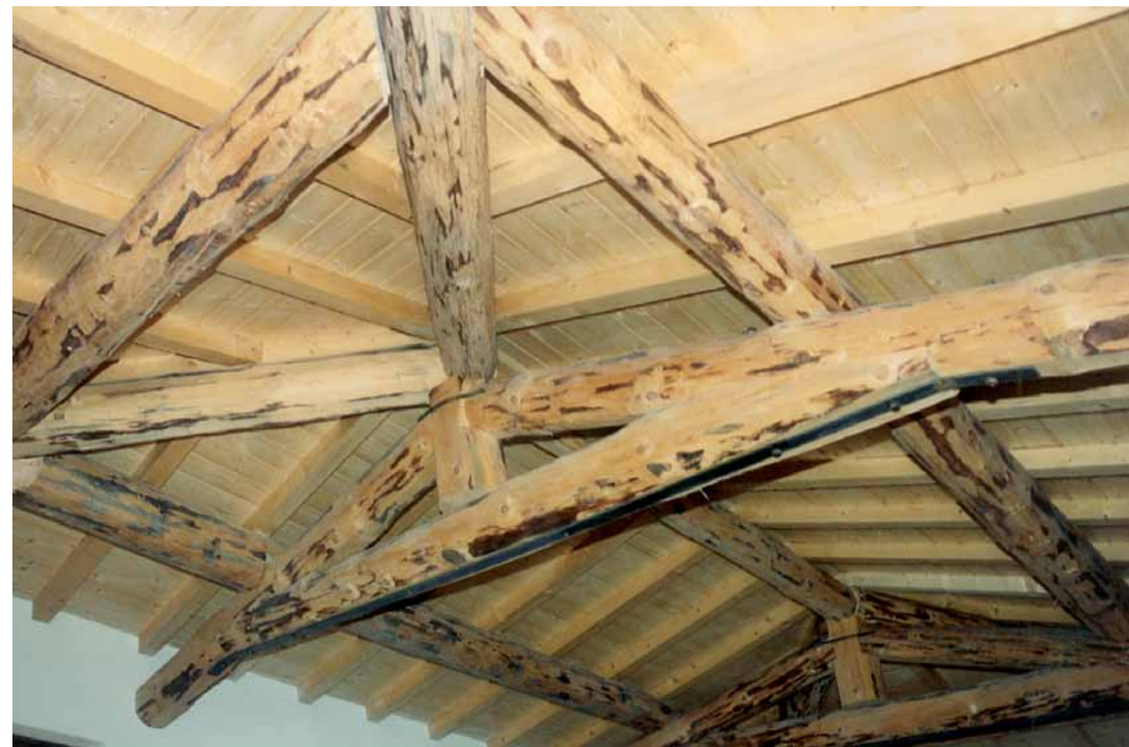
Struttura principale in abete tondo scortecciato a mano, secondario in spigolato di abete
