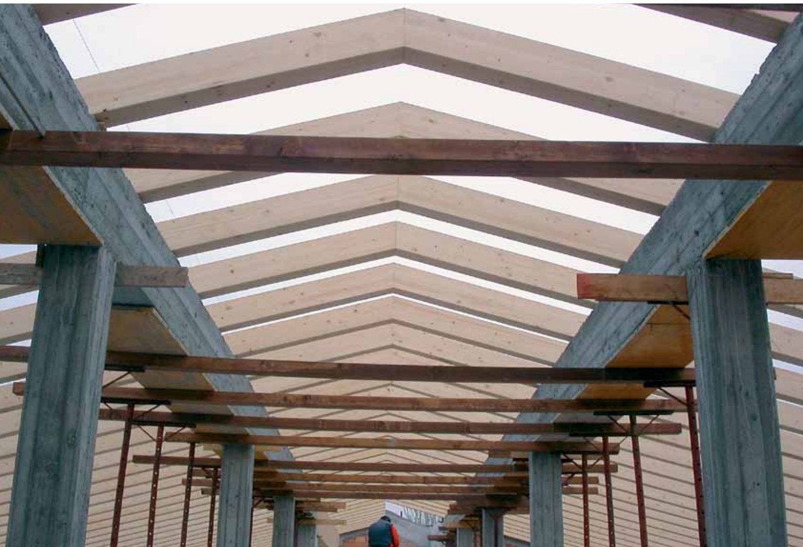
Copertura in legno su struttura portante in c.a.
