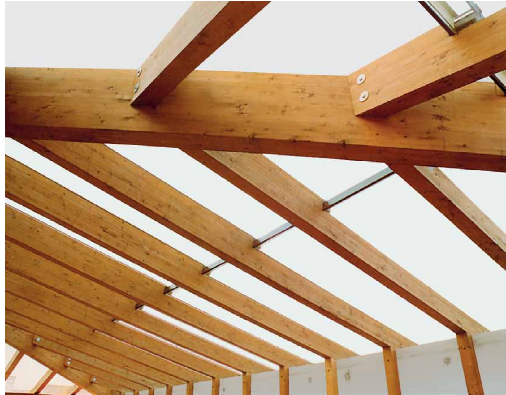
Esclusiva: struttura in legno con copertura in vetro
