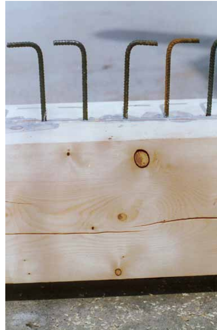
Piolatura con resina trave principale di un solaio
