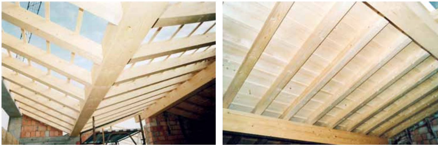
Tetti - solai: lavorazione tavola grande più listello coprigiunto
