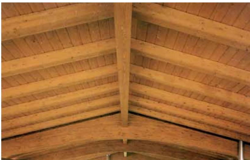
Tetto in legno lamellare portale a bifalda (boomerang) installato con colmi e terzere in luce
