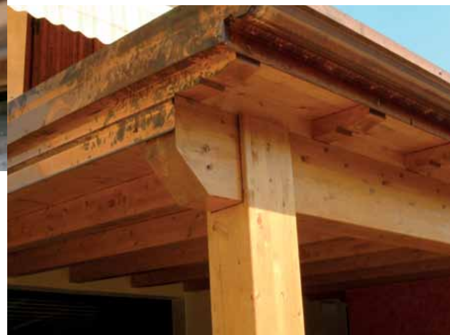
Particolare trave di colmo abbinata e spaziata
