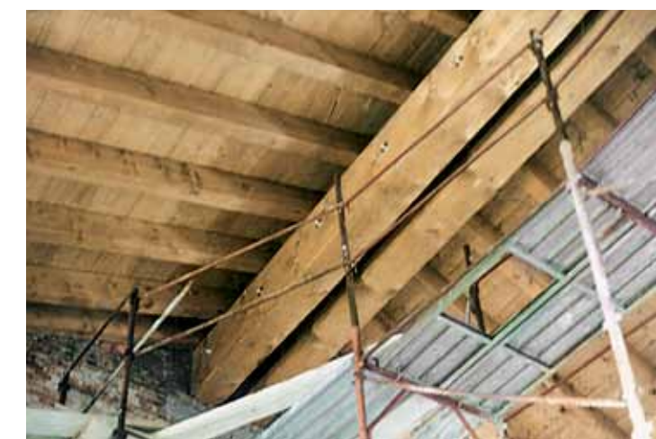
Particolare trave di colmo abbinata e spaziata
