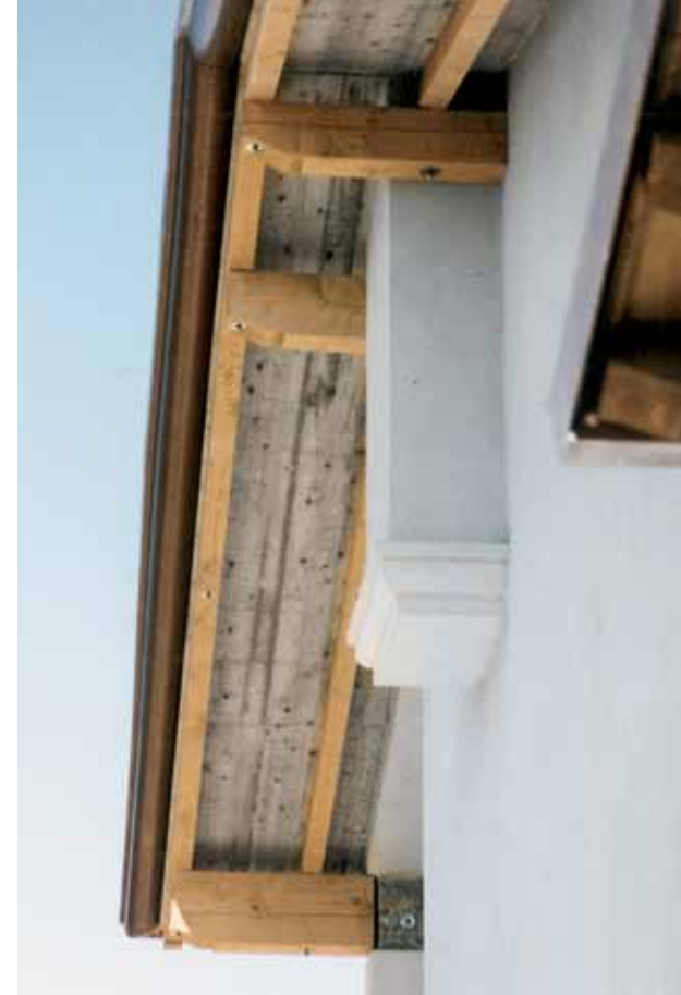
Applicazione su gronde in c.a. con travi in legno
