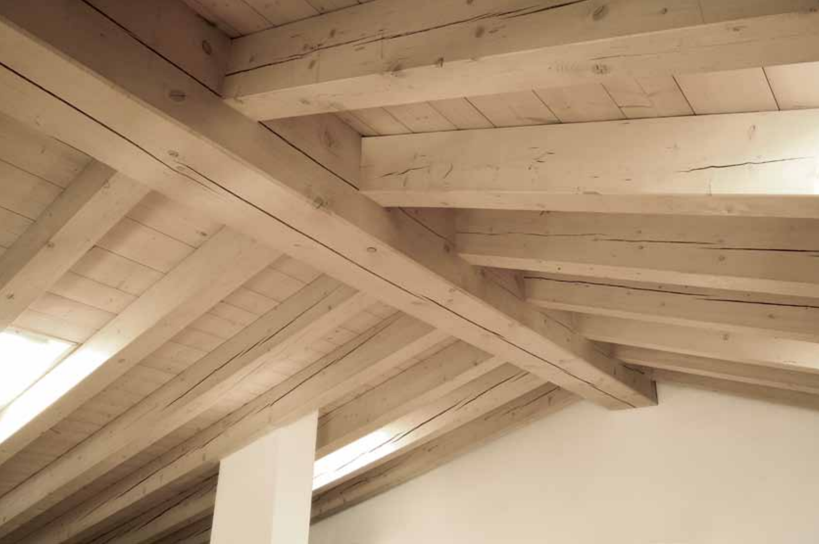
Tetto in abete massiccio installato in luce con tasche (non strutturali) e ferramenta a scomparsa con falda da ml 8,00
