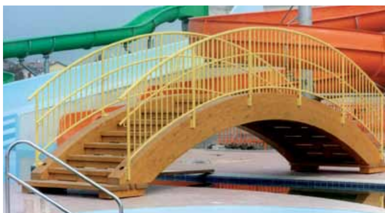
Passerella pedonale con parapetto in metallo
