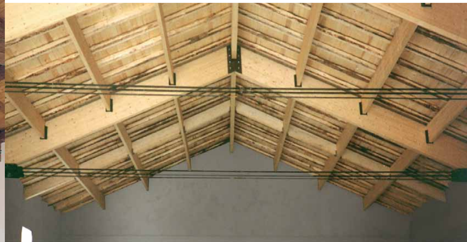
Capriate in lamellare con 3 tiranti in metallo e ferramenta a vista, terzere lamellare, travi secondarie abete uso trieste e tavolato grezzo
