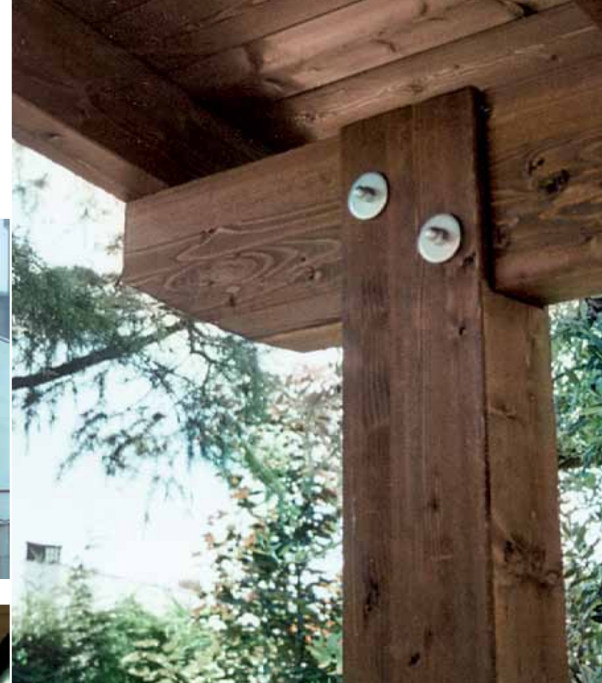
Sella per inserimento trave di banchina
